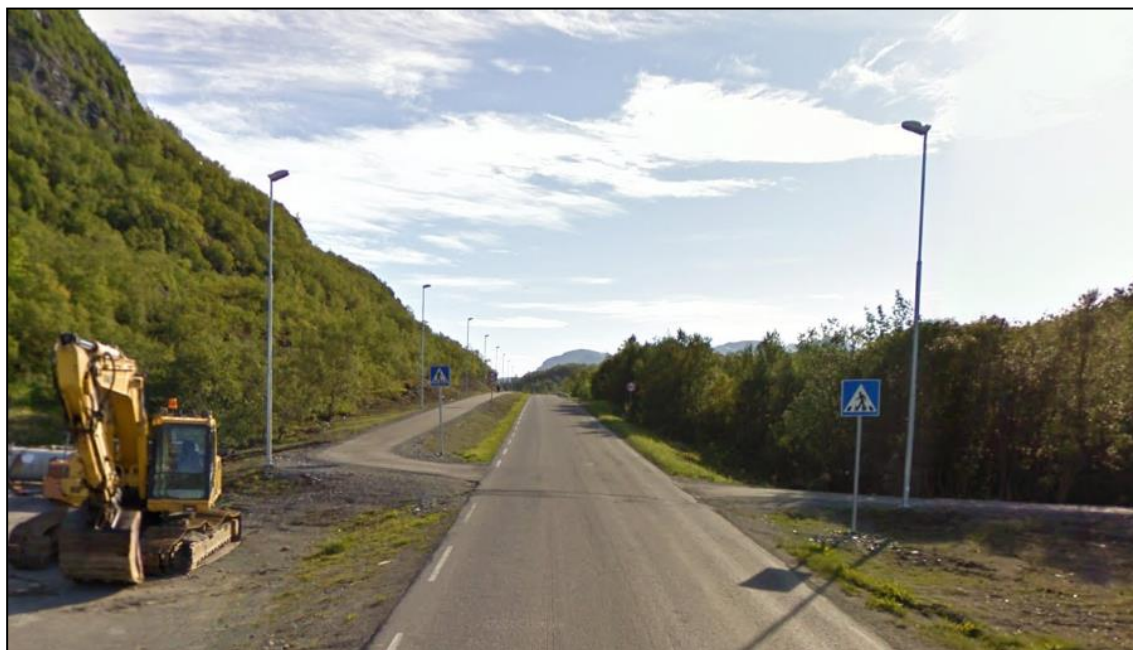
Figur 28 Gangfeltet ved Malenaveien
