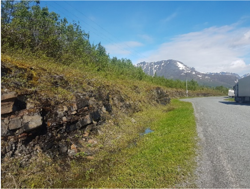
Bergskjæring. Foto: Statens vegvesen
