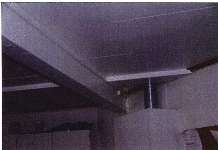
Gitterdrager (innkasset) krysser over limtre drager.
