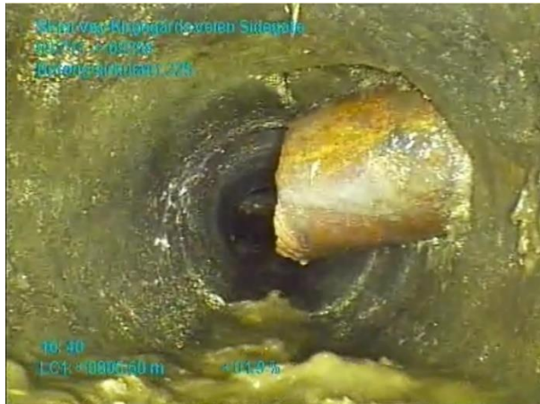
Figur 2: Fellesledning Mellomveien, innstukket rør
