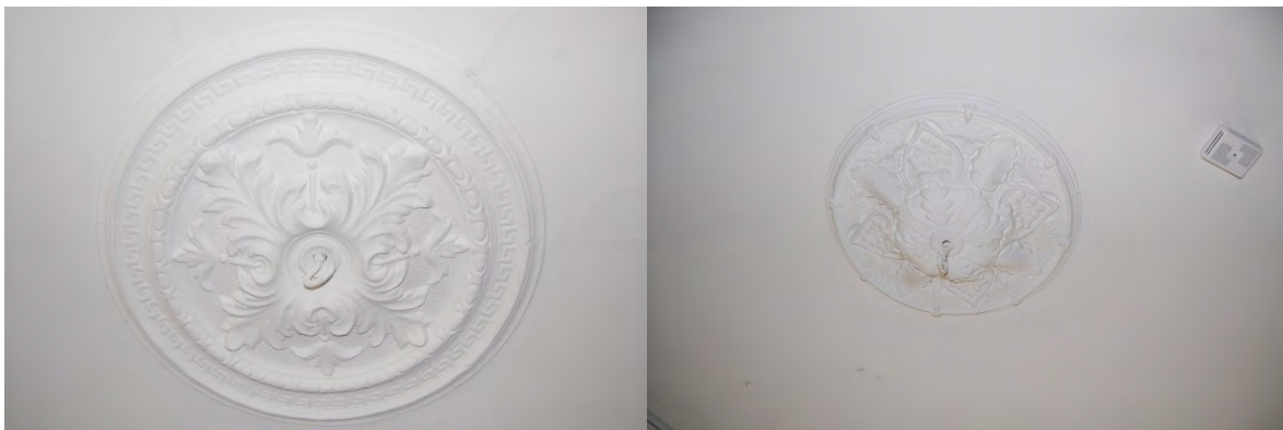
Gipsrosetter i tak i 1. etasje
