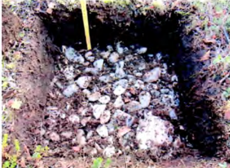
Figur 6: Bilde av prøvestikk fra sør på terrassen. P11.
