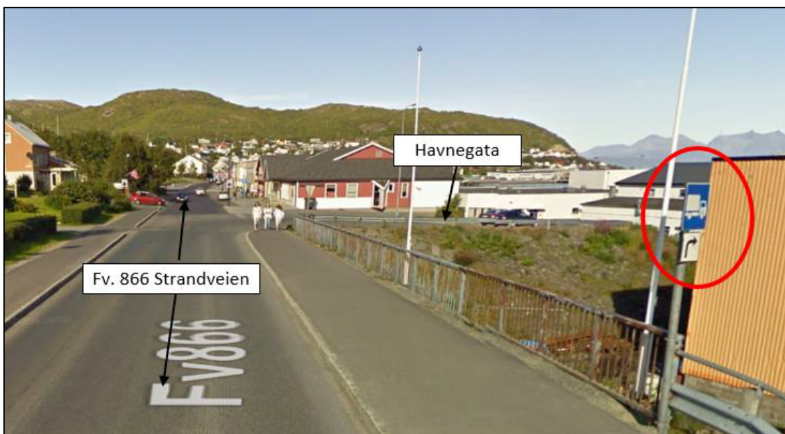
Figur 30 – Skilting som anbefaler til bruk av Havnegata, sett fra fv. 866 mot nord
