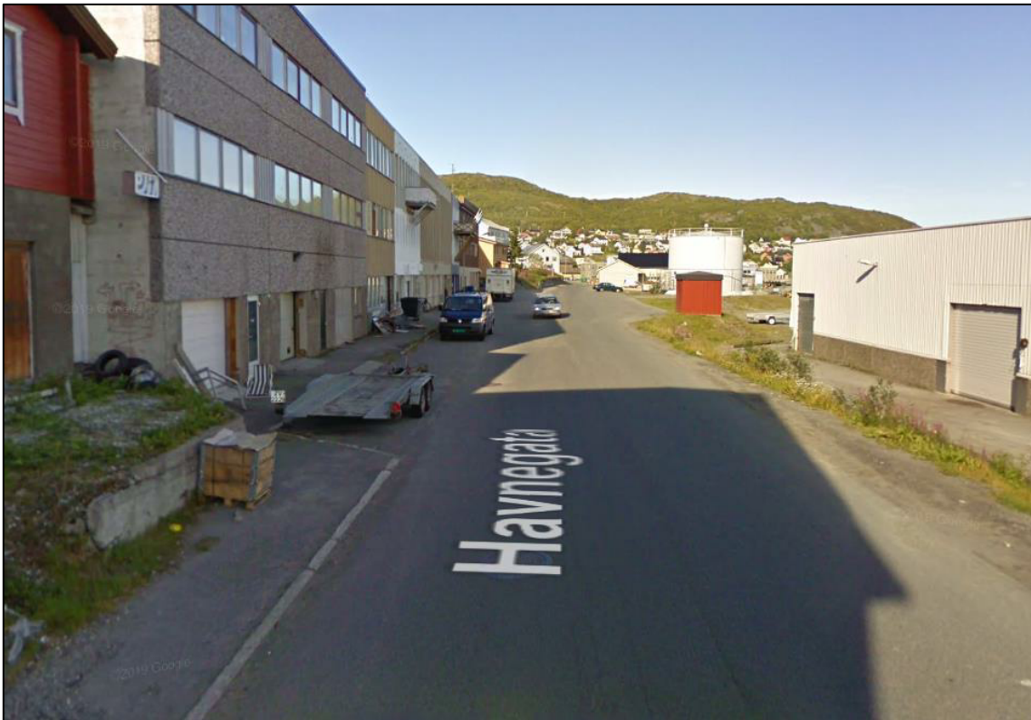
Figur 20 – Havnegata mellom de to kryssene med fv. 866 Strandveien
