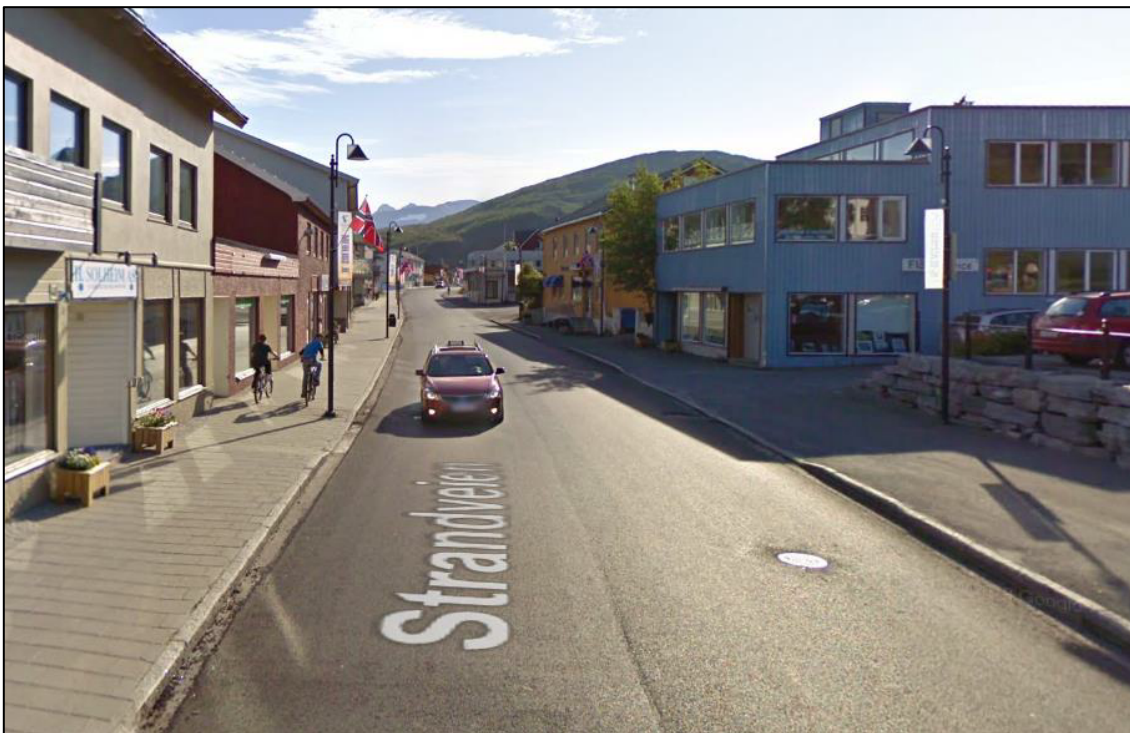
Figur 13 – Fv. 866 mellom Strandveien V og Strandveien N
